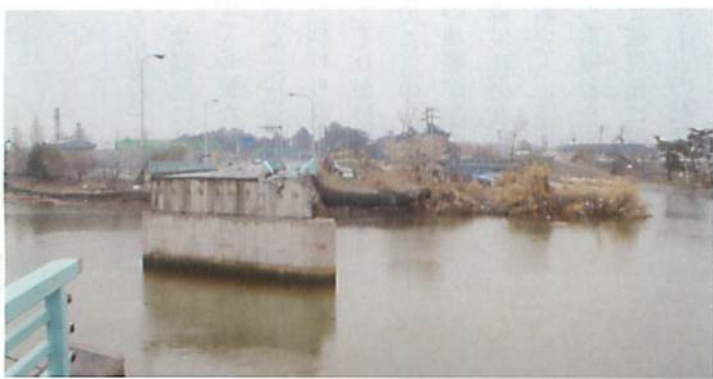
写真2 落橋後の定川大橋(石巻工業港矢本線)
