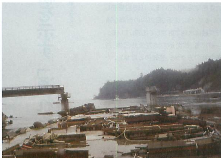
写真4 落橋した国道45号歌津大橋(南三陸町)
