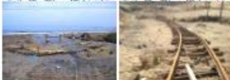
A【横けた流失】 (八戸線 宿戸～陸中八木) B【線路流失】 (八戸線 宿戸～陸中八木)
