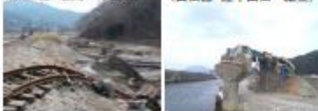
C【線路流失】 (山田線 磯崎～津軽石) D【横けた流失】 (山田線 陸中山田～磯佐)
