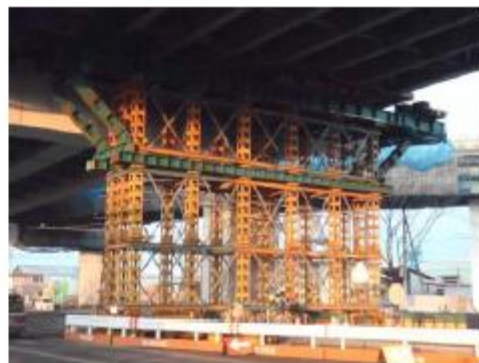
仙台東部道路 仙台東IC～仙台港北IC 東部高架橋の応急復旧状況
