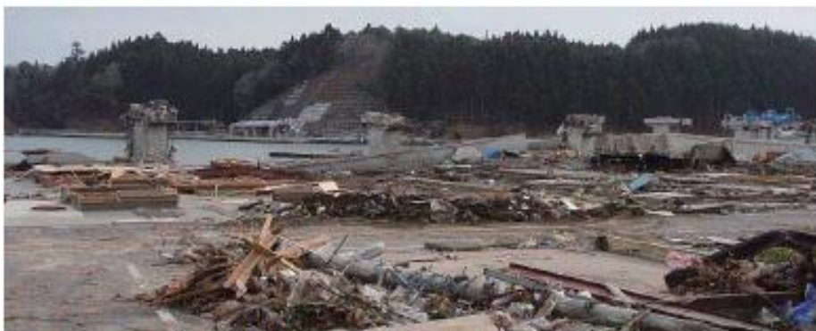
▲19南三陸町歌津宇伊里前地内(歌津大橋)
