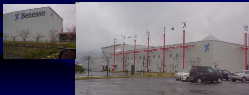
岡山県邑久郡長船町福岡工業団地
